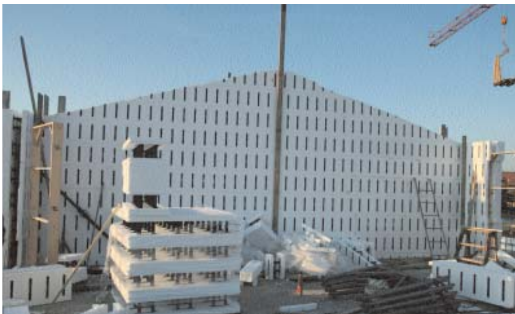
Fase dell'ultimo piano sottotetto e posa delle travi di legno per la copertura; nella foto in basso a destra vista del lato est dopo la posa del cartongesso bitumato prima della copertura con tegole in laterizio
